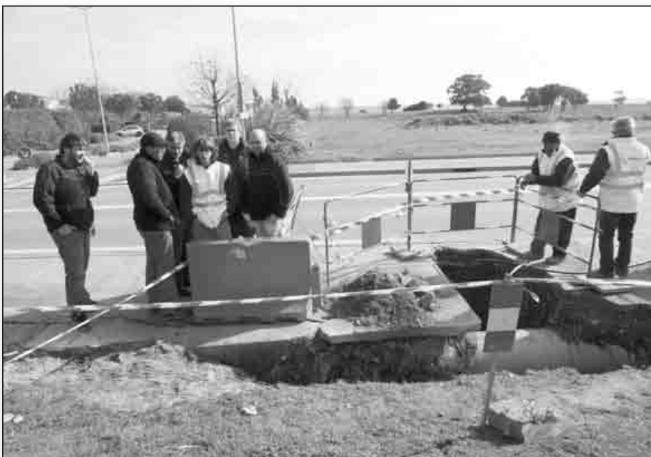
Visite du chantier de mise en conformité du réseau d'eau potable
